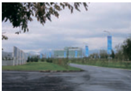
写真3 アルマティ近郊に建設が 進む広大なITパーク
