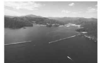
▲世界最大水深の湾口防波堤 (被災前の写真)
