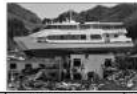
・津波により大槌町の 民宿の屋根に乗り上 げた観光船はまゆり
